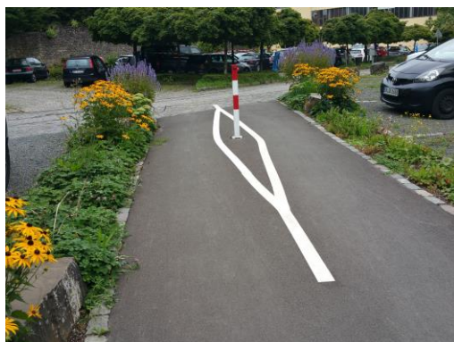
Abbildung 4-23: markierter Sperrpfosten in Engelskirchen
