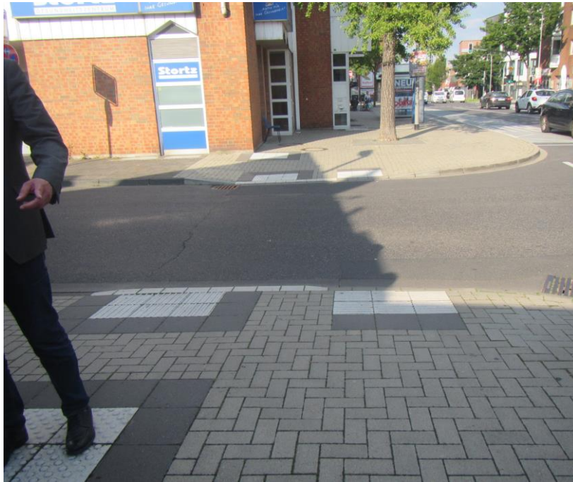
Abbildung 4-18: Beispiel einer Querung mit Doppelbord In Pulheim
