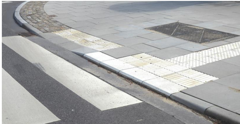
Abbildung 4-17: Differenzierte Bordhöhe an Querungsstellen
