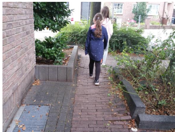
Abbildung 4-13: Gehwege in Schulumnähe weisen häufig Mängel auf oder fehlen (Lindenstraße)
