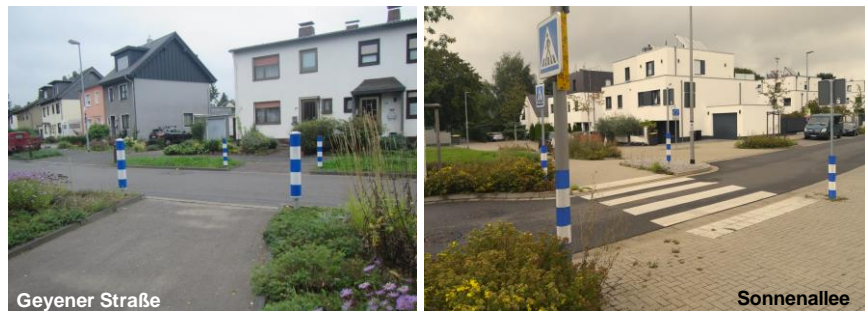
Abbildung 4-5: Einrichtung eines FGÜ an der Geyener Straße (rechts Beispiel Sonnenallee)
